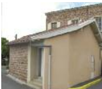
Toilettes publiques avant les travaux
